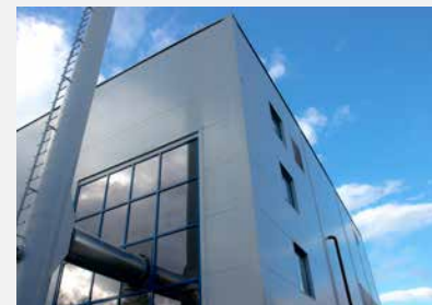
Anlegget til Alta Fjernvarme AS er totalrenovert og har fått renseanlegg slik at det kan brenne returtrevirke, ikke kun biomasse/skogflis, slik det var laget for i utgangspunktet.
